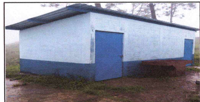
Foto 6: baños: techo y pintada completa.
